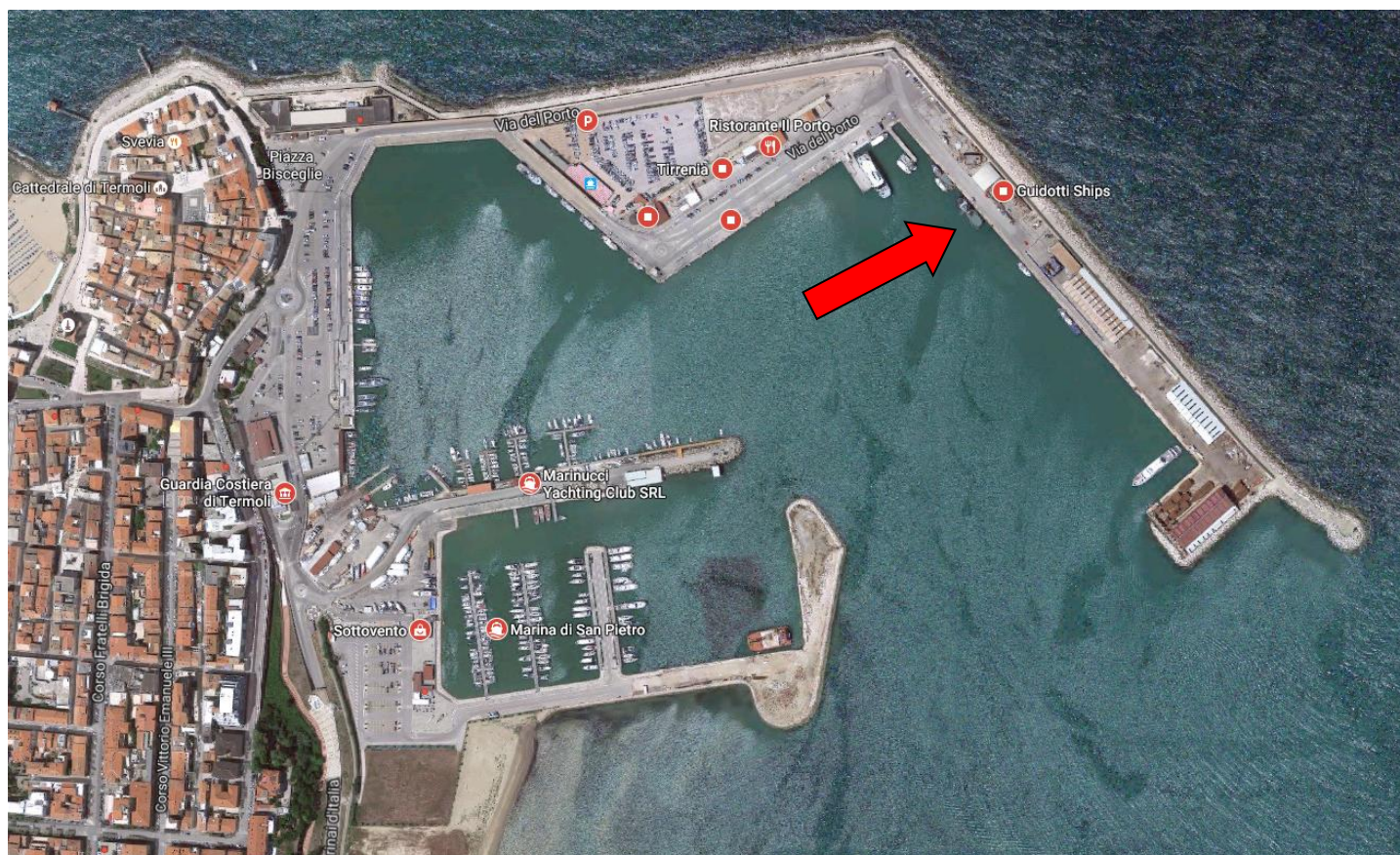
Banchina di ormeggio porto di Termoli
